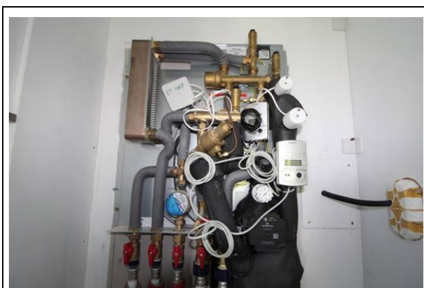
523/31/A/11 hrsz-ú lakás, vízára és hőmennyiségmérők
