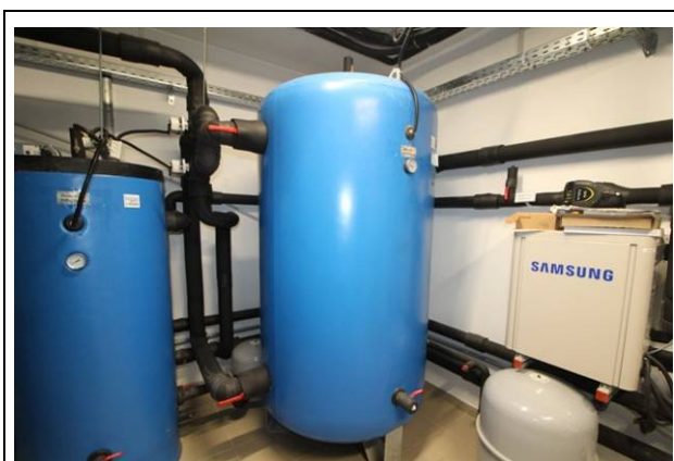
alagsori gépészeti helyiség, lakás hűtés puffertartó
