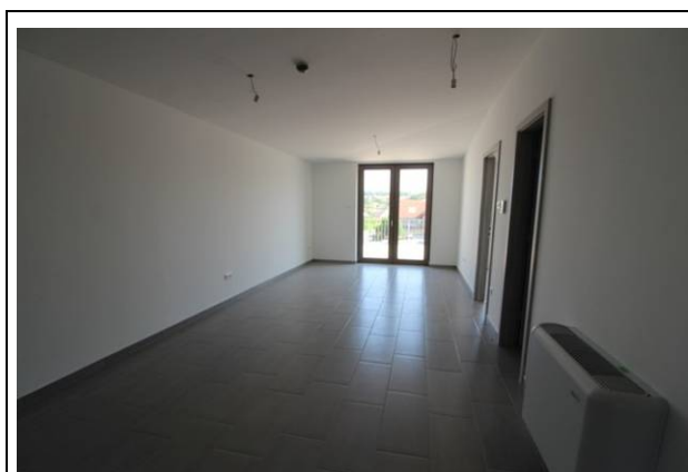
523/31/A/9 hrsz-ú lakás, nappali-konyha-étkező, fan-coil
