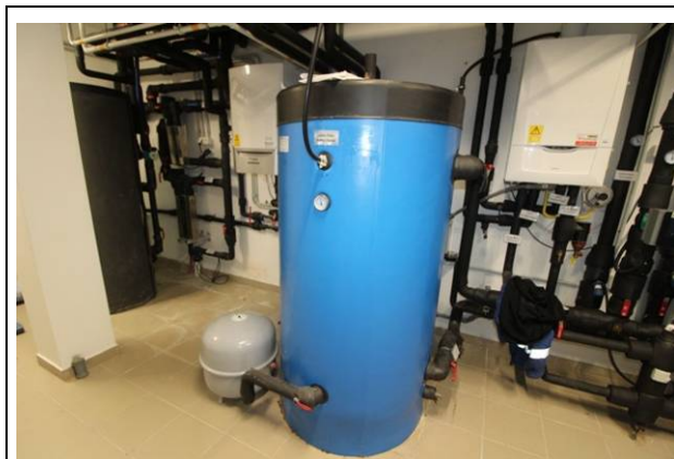
alagsori gépészeti helyiség, lakás fűtés puffertartó
