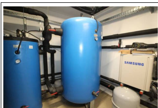
alagsori gépészeti helyiség, lakás hűtés puffertároló
