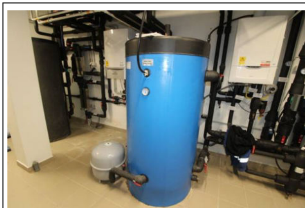
alagsori gépészeti helyiség, lakás fűtés puffertároló
