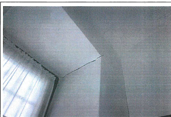
iroda, repedés a mennyezeten és a falon
